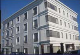
Konut Projesi Çengelköy 2500 m 2 Toprak Kaynaklı Isı Pompası
