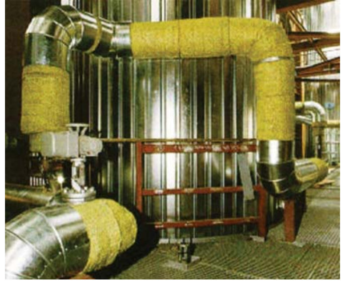
Şekil 1. Tesisata Yalıtım Uygulanması [1]
