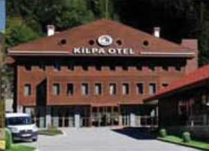
Kilpa Otel Uzun Göl - Trabzon 2600 m 2 Su Kaynaklı Isı Pompası
