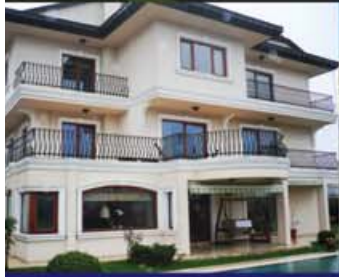
İstanbul, Acarlar villa Toprak Kaynaklı Isı Pompası
