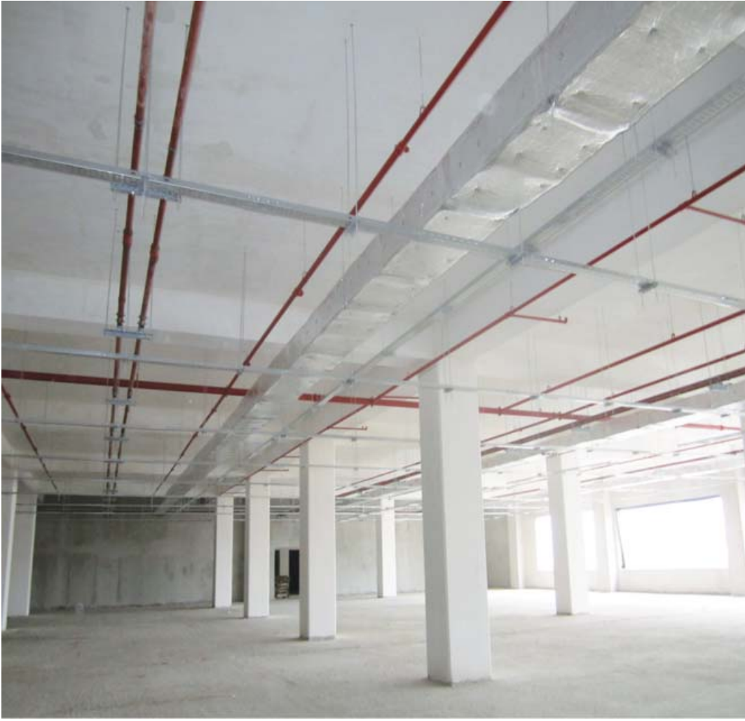
Dar Gövdeli Hangar Annex Yangın Borulama ve Kablo Tava İmalatı
