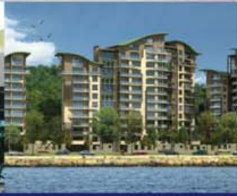
Leb-İ Derya Zonguldak Projesi Su Kaynaklı Isı Pompası
