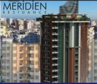
Adana, Meridien Residence Toprak Kaynaklı Isı Pompası
