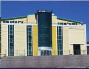
İstanbul, Etiket Fabrikası Toprak Kaynaklı Isı Pompası
