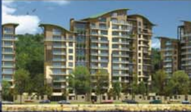
Leb-i Derya Zonguldak Konut Projesi 30.000 m 2 Su Kaynaklı Isı Pompası.
