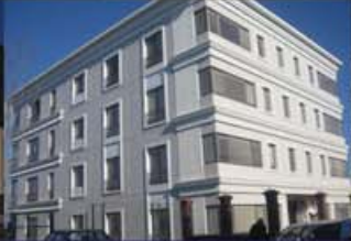
Konut Projesi Çengelköy 2500 m 2 Toprak Kaynaklı Isı Pompası
