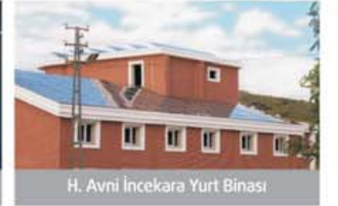
H. Avni İncekara Yurt Binası Güneş Paneli
