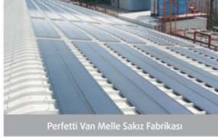
Perfetti Van Melle Sakız Fabrikası Esnek Güneş Paneli
