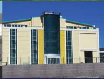
İstanbul, Etiket Fabrikası Toprak Kaynaklı Isı Pompası
