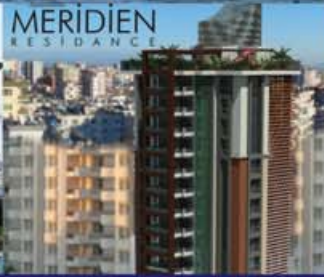
Adana, Meridien Residence Toprak Kaynaklı Isı Pompası
