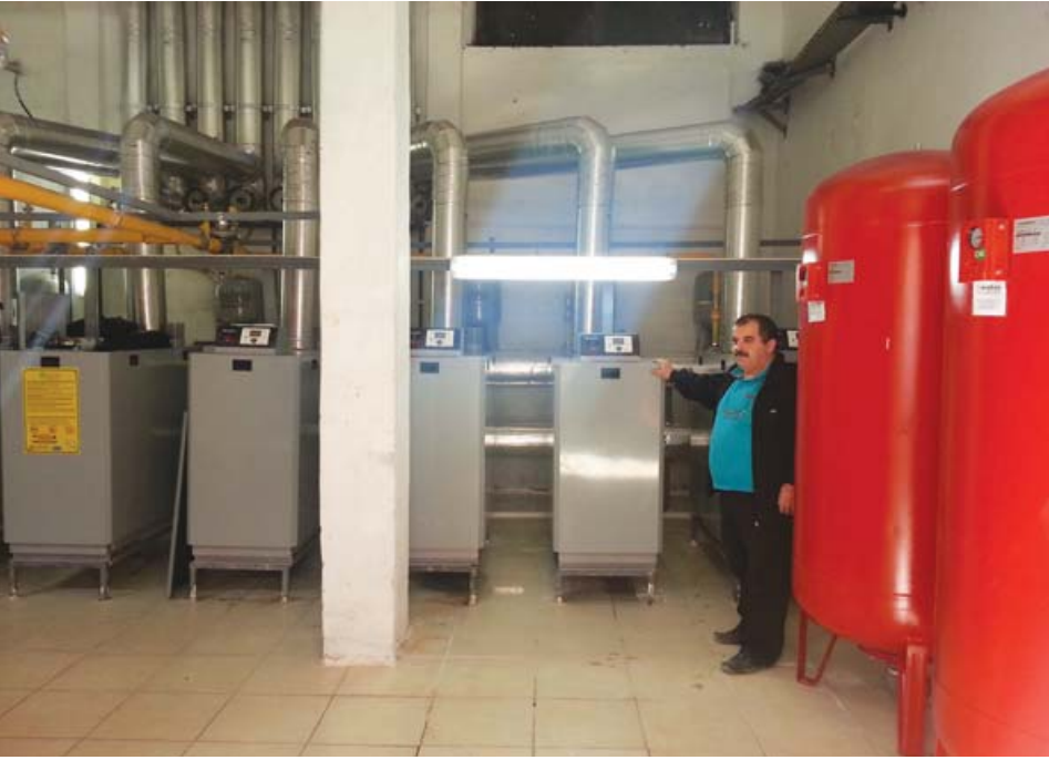
Kastamonu Dr.Münif İslamoğlu Devlet Hastanesi Kazan Dairesi ALARKO ADK-Y Serisi Yoğuşmalı Döküm Kazanlar
