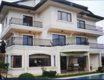
İstanbul, Acarlar villa Toprak Kaynaklı Isı Pompası
