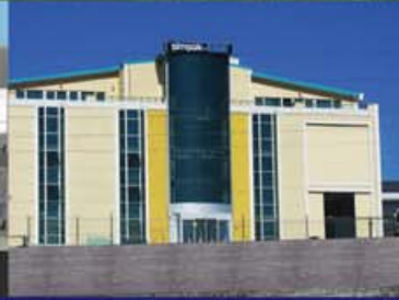
İstanbul, Etiket Fabrikası Toprak Kaynaklı Isı Pompası
