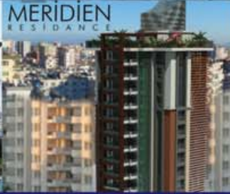
Adana, Meridien Residence Toprak Kaynaklı Isı Pompası
