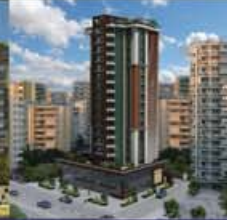
Konut Projesi Bayas İnşaat 2940 m 2 Toprak Kaynaklı Isı Pompası
