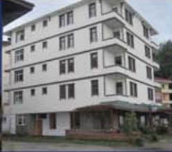
Cansızoglu Otel Ol-Trabzon 750 m 2 Toprak Kaynaklı Isı Pompası
