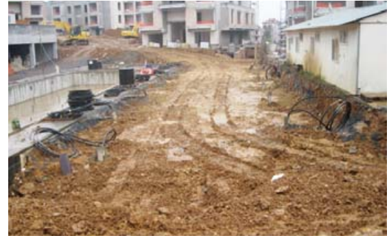
Dikey Borulama Yapılan Alan
