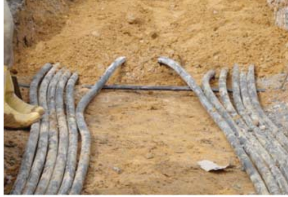
Kuyulardan Saha Kolektörüne Çekilen Yatay Borular
