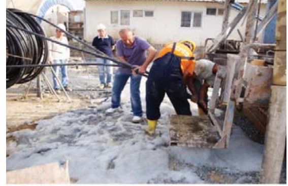
Açılan sondaj kuyusuna boru indirilmesi
