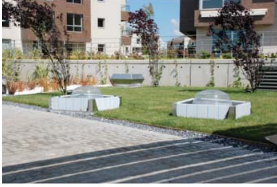
Bina Zemin Kat Koridorunda Gün IşığI Aydınlatma Üniteleri
