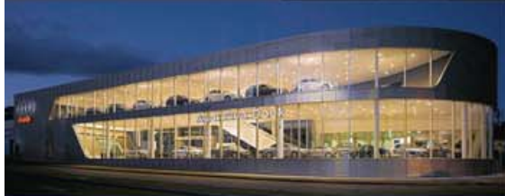
Audi VW Showroom İstanbul Projesi 18.000 m 2 Su Kaynaklı Isı Pompası.
