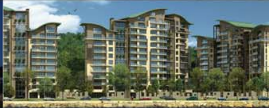
Leb-I Derya Zonguldak Projesi 30.000 m 2 Su Kaynaklı Isı Pompası.
