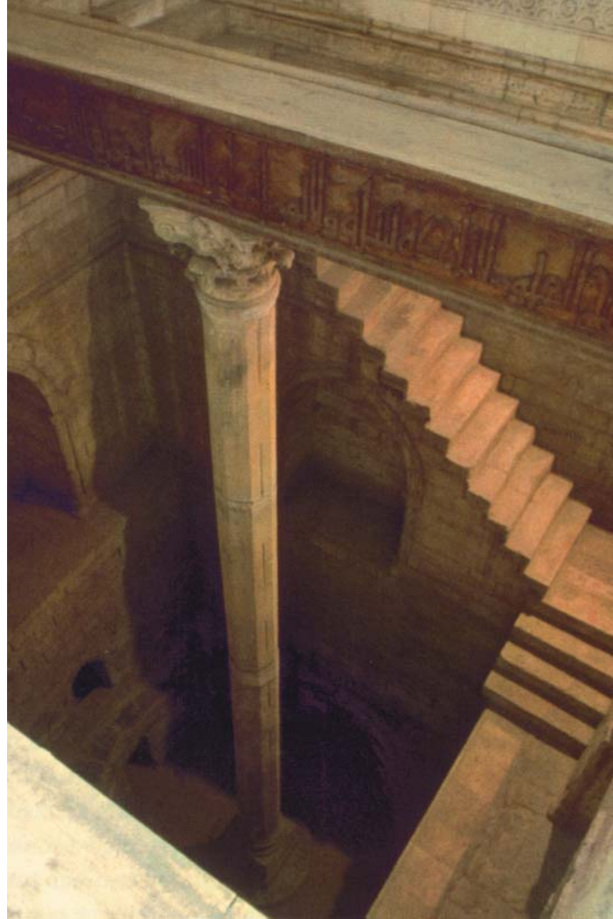
Rawada adasında Kahire yakınlarındaki Fustat'ta bulunan Nilometre İ.S. 861-861 yıllarında tamamlandı. Merkezdeki oktagonel kolon Nil'in su yüksekliğini kûbitlerle ölçmek için kullanılıyor.
