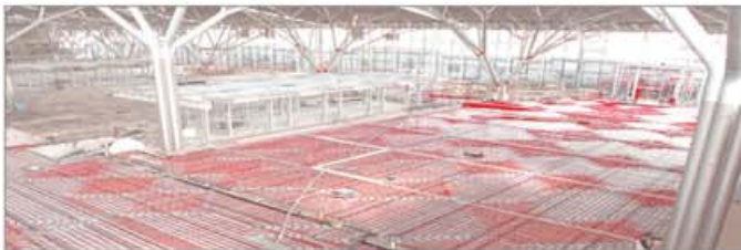
Endüstriyel Yerden Isıtma / Serinletme
