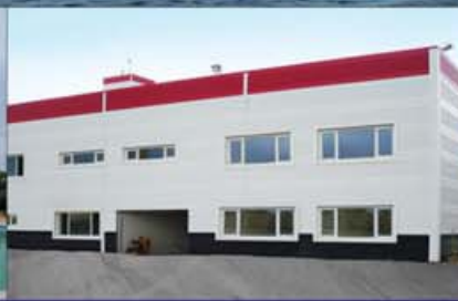
Diyarbakır, Alçıpan Fabrikası Toprak Kaynaklı Isı Pompası
