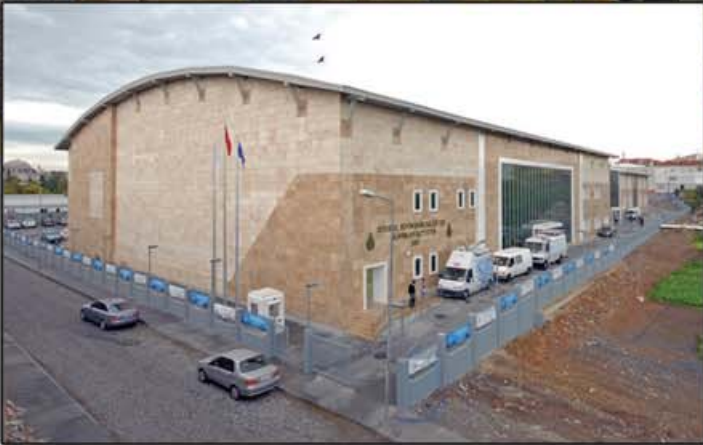
İstanbul Büyükşehir Belediyesi Silivrikapı Buz Pateni Tesisleri Frigo Mekanik tarafından yapıldı
