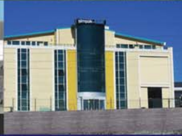
İstanbul, Etiket Fabrikası Toprak Kaynaklı Isı Pompası
