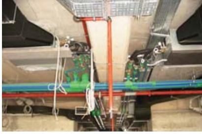
Fancoil Bağlantı Tekniği
