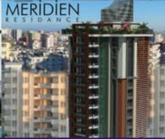
Adana, Meridien Residence Toprak Kaynaklı Isı Pompası
