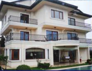
İstanbul, Acarlar villa Toprak Kaynaklı Isı Pompası
