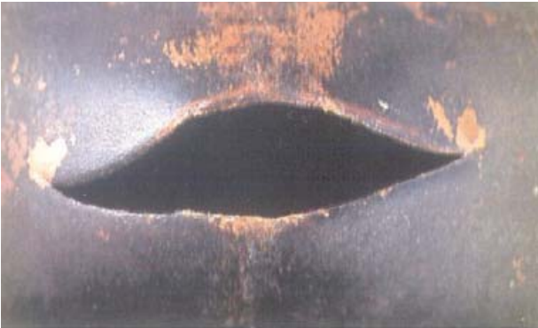
Evaporatör borusu içerisinde geçen akışkanın donması sebebiyle meydana gelen yarıma ve çatlama etkisi.
