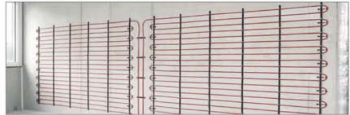
Konut Uygulamaları-Duvardan Isıtma / Serinletme
