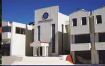
Ankara Meslek Okulları Ankara Projesi 3.500 m 2 Toprak Kaynaklı Isı Pompası.
