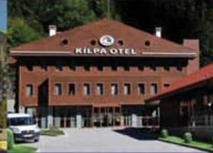
Kilpa Otel Uzun Göl - Trabzon 2600 m 2 Su Kaynaklı Isı Pompası
