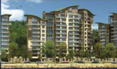
Leb-i Derya Zonguldak Konut Projesi 30.000 m 2 Su Kaynaklı Isı Pompası.
