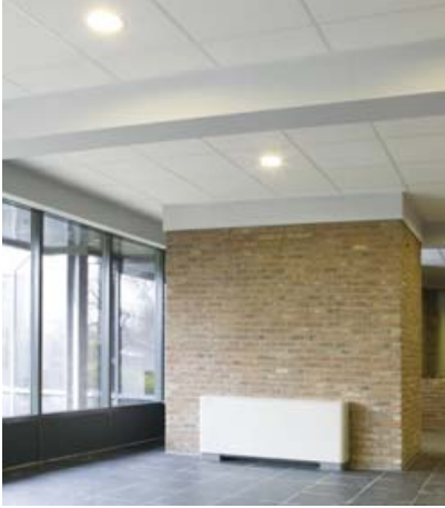
Kasetli Döşeme Tipi Uygulaması
