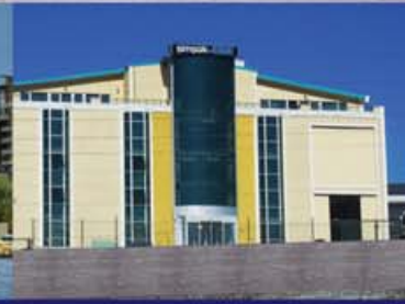
Istanbul, Etiket Fabrikası Toprak Kaynaklı Isı Pompası
