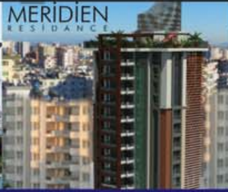
Adana, Meridien Residence Toprak Kaynaklı Isı Pompası
