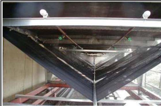
Sekil 1.A, 1.B Dik ve Yatık Tip Ağ Üzeri Su Spreyleme Sistemli Hava Soğutmalı Kondenserler [3], [1]
