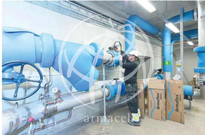
Resim 2: Armaflex Ultima Uygulaması
