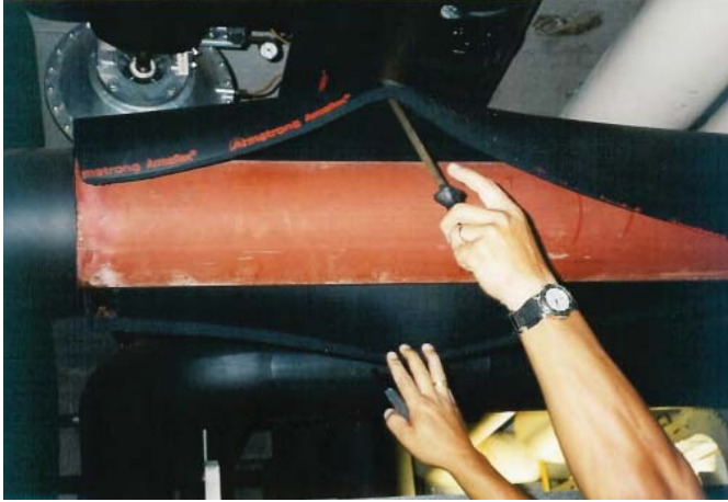
Resim 1: 20 yıl sonra kontrol amaçlı açılan AF Armaflex yalıtımı. Görevini mükemmel yaparken, alttaki yapıya da mükemmel bir koruma sağlamış.
