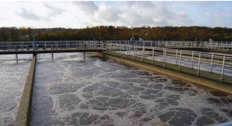
Şekil 1: Danimarka Aarhus'daki bu su arıtma tesisi ileri süreç kontrolü ve daha fazla VLT AQUA Sürücü kullanarak enerjinin tanımını değiştirmiştir. Artık konu %60'lık enerji tasarrufuyla değil tüm tesisteki enerjinin net üretimiyle ilgilidir.
