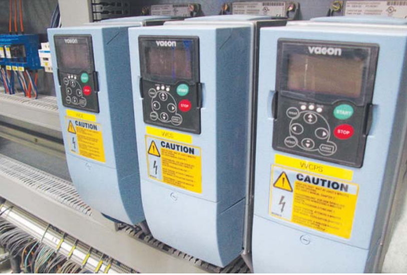
Şekil 3: 400 kW sürücülere ek olarak, 26 adet 2-3 kW'lık Vacon NXP AC motor sürücüler, teleferikleri istasyon içinde ve garajda hareket ettirmede kullanılan motorlu redüktörleri kontrol etmekte kullanılıyor.
