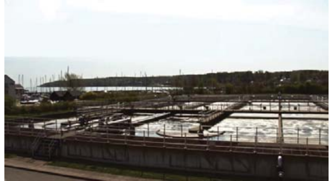
Şekil 5: Danimarka Marselisborg'daki su arıtma tesisi
