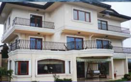
Acarlar villa Toprak Kaynaklı Isı Pompası
