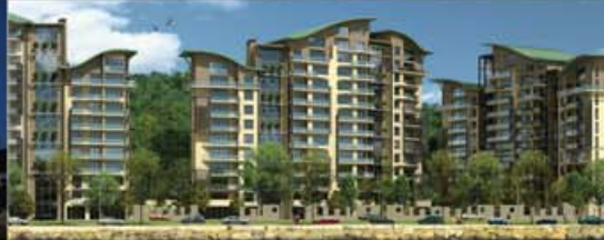
Leb-İ Derya Zonguldak Konut Projesi 30.000 m 2 Su Kaynaklı Isı Pompası.
