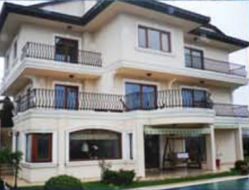
İstanbul, Acarlar villa Toprak Kaynaklı Isı Pompası
