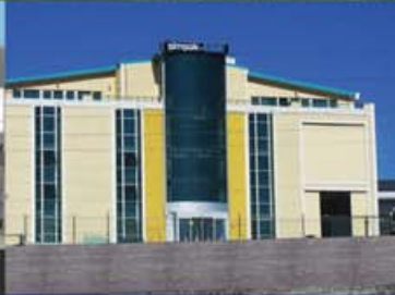
İstanbul, Etiket Fabrikası Toprak Kaynaklı Isı Pompası
