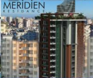
Adana, Meridien Residence Toprak Kaynaklı Isı Pompası
