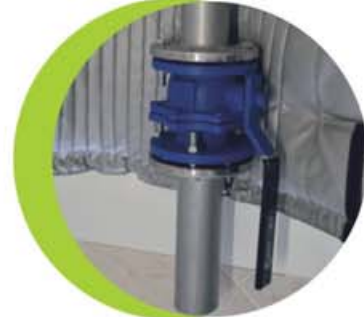
Buhar Kazanı Ekipmanları Yalıtım Insulation of Boiler Equipment
