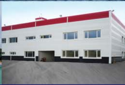
Dişarbakır, Alçıpan Fabrikası Toprak Kaynaklı Isı Pompası
