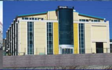
İstanbul, Etiket Fabrikası Toprak Kaynaklı Isı Pompası
