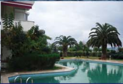
Dragos, Rezidans Dairesi Hava Kaynaklı Isı Pompası
