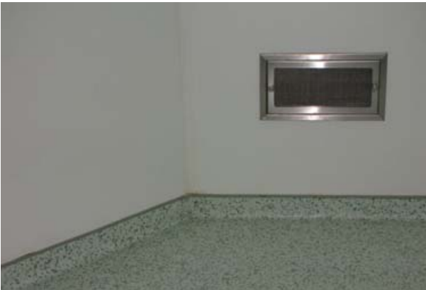
Şekil 3.4 Kondaktif zemin kaplaması ve köşe detayı
