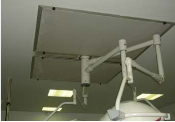
Sekil 5. Laminar akış uygulaması
