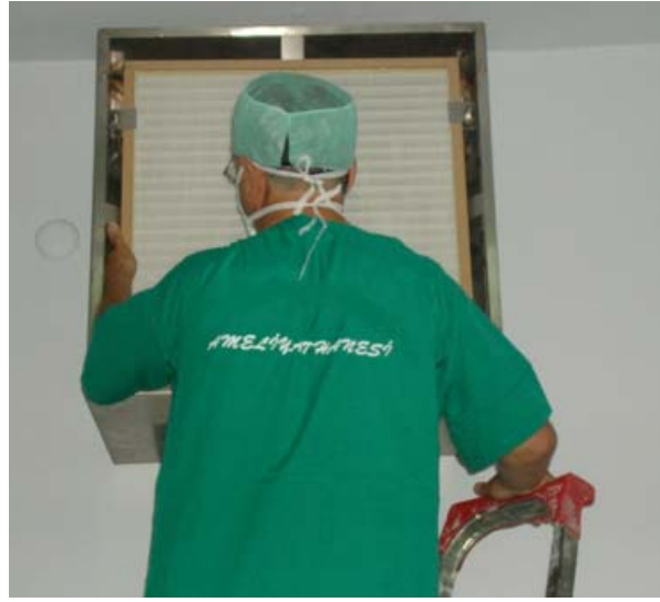
Şekil 3. HEPA Filtre bağlantısının kontrolü
