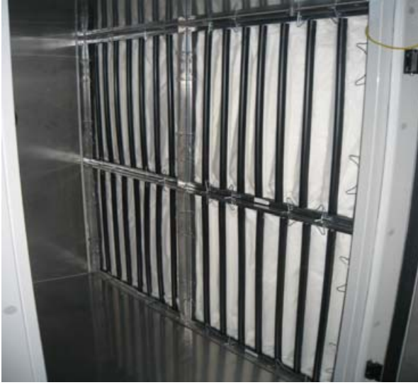
Şekil 1. Örnek F9 sınıfı hassas filtre (torba filtre) uygulaması
