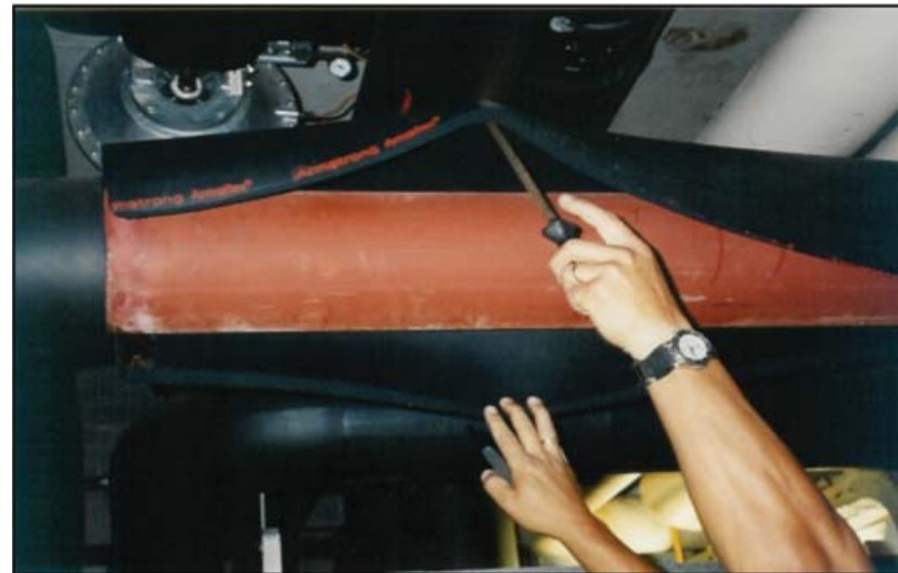
Resim 5: 20 yıllık kullanımdan sonra dahi fiziki özelliklerini ve boruyu koruyan Armacecell yalıtımı
